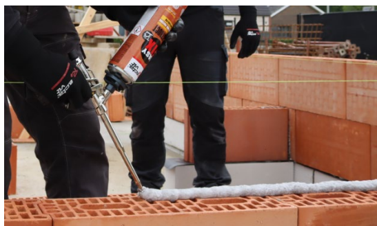
Figuur 1: aanbrengen van de lijm
